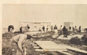
Die erste Häuserwand steht (6 Uhr)
