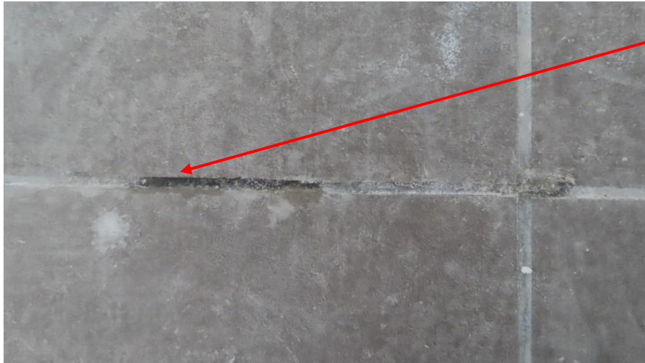
מדידת תכולת רטיבות במישקים בריצוף המקלחת בעזרת מכשיר protimeter:
