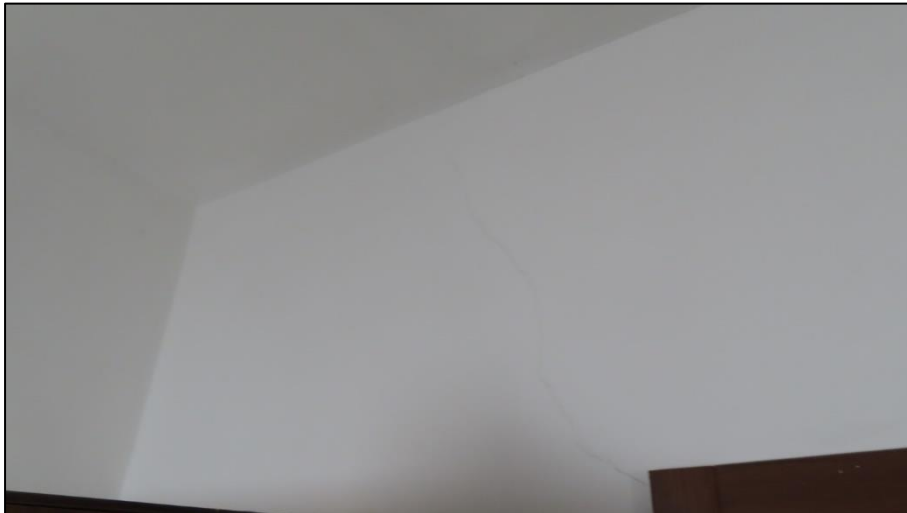
סדק אלכסוני על גבי קיר משותף למטבח ולחדר שינה 1, מבט מכיוון חדר שינה:
