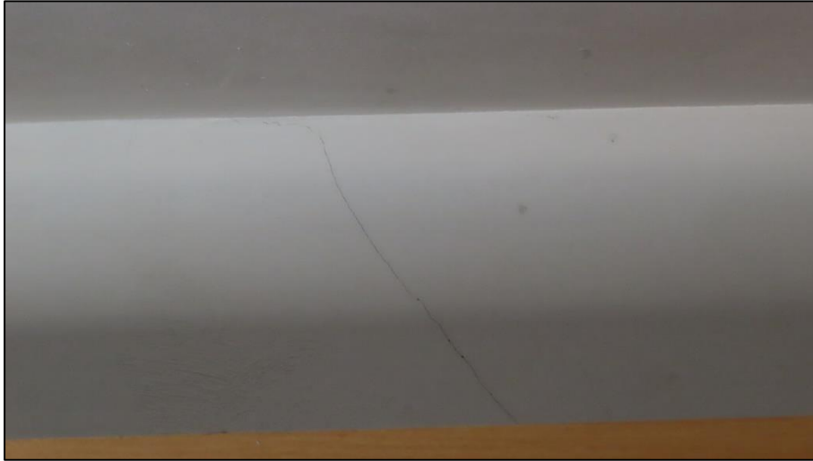
סדק אלכסוני על גבי קיר משותף למטבח ולחדר שינה 1, מבט מכיוון חדר שינה:
